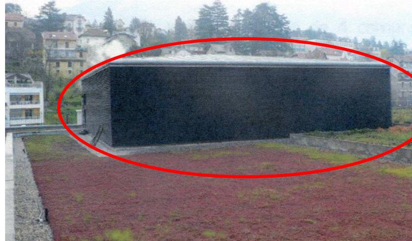
REGROUPEMENT DANS UN LOCAL, AVEC BARDAGE PHONIQUE, INDEPENDANT DE LA STRUCTURE: DES SYSTEMES DE VENTILATION (FROID, CHAUFFERIE)
